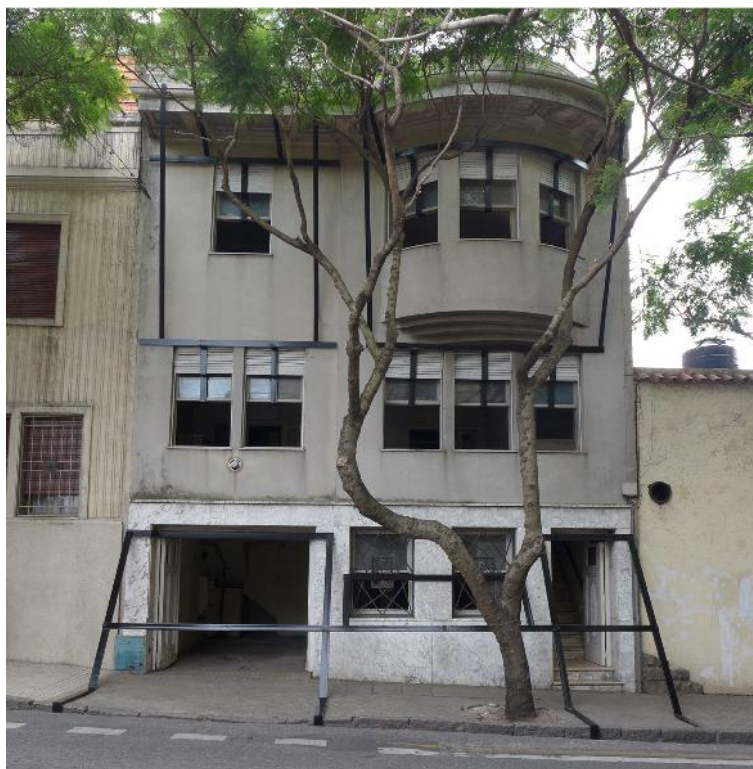
Registro de la intervención El inicio del movimiento realizado por Valeria Galliso y Guido Leveratto
