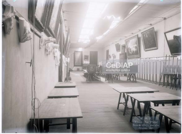
Figura 1. Ministerio de Obras Pública (La Plata). Sala de dibujo, piso alto. Febrero de 1919. Centro de Documentación e Investigación de la Arquitectura Pública
