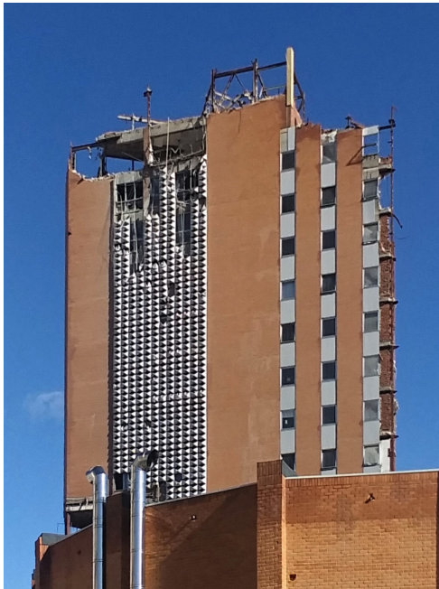
Figura 3. Palleiro-Sánchez (2026), Estructura revelada . Fuente: registro propio
