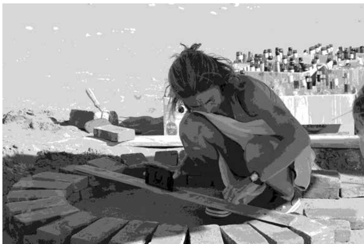
Figura 1. Comienzo de la construcción del horno
